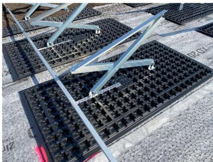
Durch Auflast gehaltene Anschlageinrichtung gemäss EN 795 Klasse E mit horizontal beweglichem Anschlagpunkt für kurzzeitige Arbeiten mit einer Persönlichen Schutzausrüstung (z. B. ZinCo Fallnet® PSA-Set, Art.-Nr. 9024) auf Flachdächern bis max. 5° Dachneigung.
