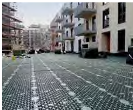
In den Hohlräumen der vollflächig verlegten RSX 80-Elemente können mehr als 75 l/m 2 Regenwasser zwischengespeichert werden.
