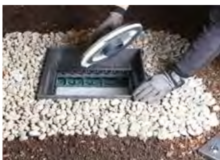
Das Retentionsdrossel-Set RDS 28 eignet sich für alle Flachdachabläufe mit angeschäumter Anschlussbahn.
