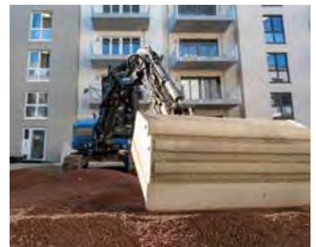
Dank des stabilen-Systemaufbaus mit RSX 80 ist das Befahren mit Baggern zur Substrataufbringung kein Problem. © Strassen- und Tiefbau Urban GmbH
