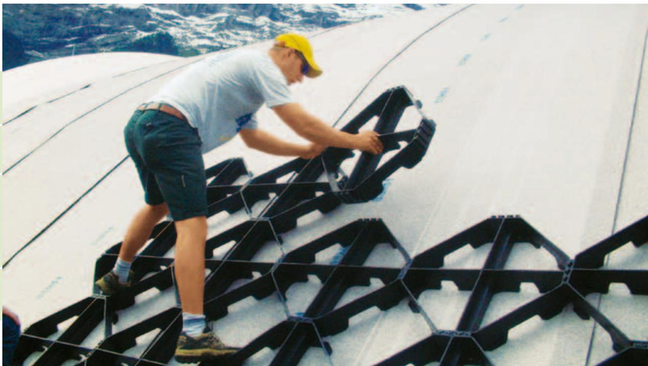
Avec le système « Toiture à forte pente végétalisée » présenté ci-contre, ayant pour base les éléments Georaster®, la végétalisation de toitures inclinées à plus de 25° devient possible. Les éléments Georaster® en polyéthylène recyclé (PEHD) sont brevetés. Ils s'emboîtent les uns dans les autres sans outil particulier. Chaque élément mesure environ 54 x 54 cm pour 10 cm de haut.
