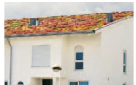
Sur ce toit à une pente, on a placé un seuil de retenue juste au-dessus du chéneau. L'évacuation des eaux se fait par une gouttière extérieure.
