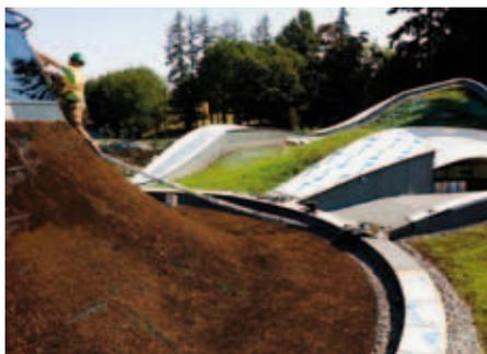
Pour cela, les surfaces inclinées à 45° du cône tronqué ont été divisées en segments circulaires à l'aide de traverses anti-poussée. Après la pose de la natte de retenue d'eau WSM 150, les éléments Georaster® ont été ajustés.
