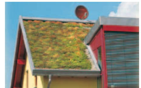
Sur ce toit en pente de 30°, une traverse supplémentaire fixée mécaniquement sur le support évite de reporter tous les efforts de poussée sur le bord de rive stabilisé.
