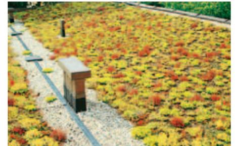
Cette toiture, avec une pente d'environ 5 %, drainée à la noue par un caniveau ne nécessite pas de mesures particulières.
