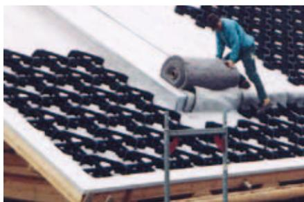
Les éléments Georaster® sont posés, en commençant par le bas, sur une natte de retenue d'eau WSM 150 préalablement déroulée sur l'étanchéité.
