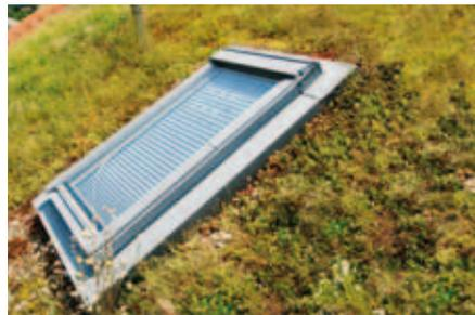
En cas d'ouvertures dans le toit, il faudra veiller à ce que l'étanchéité dépasse le bord supérieur de la couche de substrat d'au moins 12 cm. La retenue des végétalisations peut se faire par exemple au moyen du profil de rive TRP 140 en acier inoxydable combiné à des supports de retenue (crochets d'arrimage TSH ou SchubFix LF).
