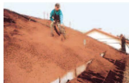
Les éléments Georaster® sont ensuite remplis avec ZincoTerre « Lavendelheide ». Le substrat compacté doit recouvrir les éléments Georaster® d'1 cm. Ce substrat peut être soufflé sur le toit à partir d'un camion-silo.
