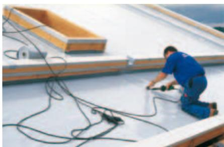
La surface du toit à végétaliser est protégée par une membrane d'étanchéité antiracines conformément aux règles FLL.
