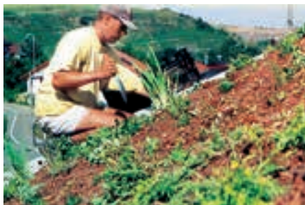
Infine si esegue la piantumazione del tetto con diverse varietà di Sedum e di altre perenni.
