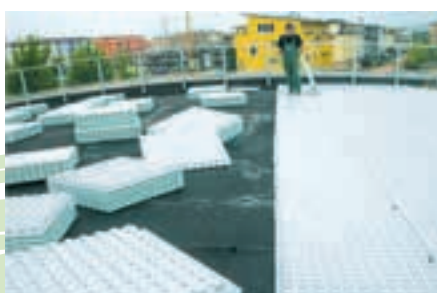
Dopo la posa degli elementi Floratherm® sono stati applicati tramite soffiaggio ca. 15 cm di substrato intensivo.
