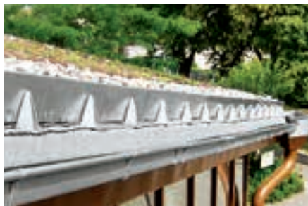
Su questo tetto con un'inclinazione di 30°, in aggiunta allo spigolo di gronda stabile, è stato installato un ulteriore profilo antispinta all'interno della superficie del tetto.
