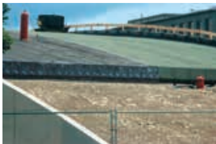
La zona di transizione tra tetto e zona di vegetazione è stata coperta con pietrisco e humus.
