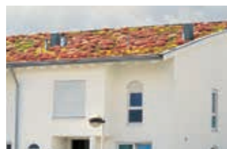
Su questo tetto a una falda è stato posato un profilo antispinta appena sopra alla gronda. Il drenaggio avviene tramite una gronda esterna.
