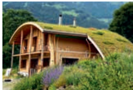
Già dopo un periodo vegetativo si osserva una copertura vegetativa estremamente uniforme. Il drenaggio della superficie del tetto avviene, nell'esempio illustrato, tramite una gronda posizionata esternamente, nella quale tre doccioni fanno affluire l'acqua in eccesso.
