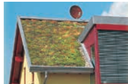
Su questo tetto con un'inclinazione di 30°, in aggiunta allo spigolo di gronda stabile, è stato installato un ulteriore profilo antispinta all'interno della superficie del tetto.
