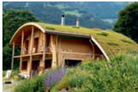
Bereits nach einer Vegetationsperiode zeigt sich die Pflanzendecke weitgehend geschlossen. Die Entwässerung der Dachfläche erfolgt im vorgestellten Beispiel über eine aussen liegende Dachrinne, in die drei Wasserspeicher das Überschusswasser einleiten.
