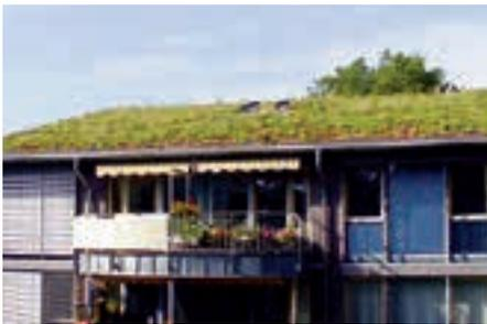
Für die Dimensionierung von Traufaufkantungen oder Schubschwellen ist nicht nur das Feuchtgewicht des Begrünungsaufbaus massgeblich, sondern auch die örtlich anzusetzende Schneelast.
