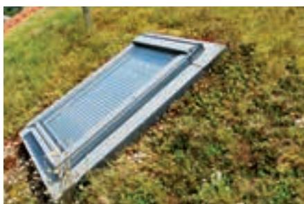
Bei Dachdurchdringungen ist darauf zu achten, dass die Abdichtung mindestens 12 cm über die Oberkante der Substratschicht herausgeführt wird. Begrünungen können zum Beispiel mittels Traufprofil TRP 140 aus Edelstahl in Kombination mit Schubhaltern (Traufschubhalter TSH oder SchubFix LF) eingefasst werden.
