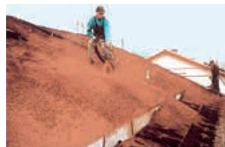
Die Zincoterre® „Lavendelheide“ wird z. B. im Silozug angeliefert und per Schlauchleitung solange auf das Dach geblasen, bis die Georaster®-Elemente ca. 1 cm überdeckt sind.
