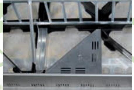
Komplettiert wird das System durch den Steildach-Kontrollschacht zum Einbau über dem Ablauf bei innen liegender Entwässerung.
