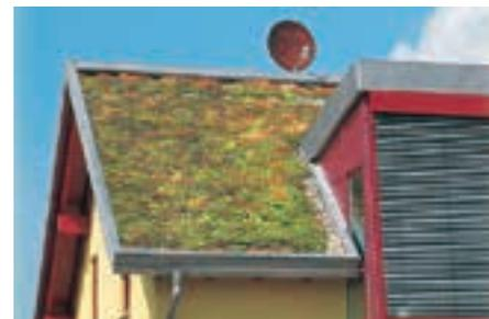
Bei diesem ca. 30° geneigten Dach wurde zusätzlich zur stabilen Traufaufkantung eine weitere Schubschwelle innerhalb der Dachfläche vorgesehen.
