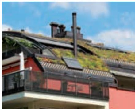
Für Tonnendächer gibt es keine Standardlösung. In Zusammenarbeit mit der ZinCo Anwendungstechnik werden jedoch objektspezifische Lösungen erarbeitet, wie z. B. auf den Dächern von Mehrfamilienhäusern in Pfäffikon (Bild oben). Bei extremen Dachneigungen können keine Kiesrandstreifen ausgeführt werden. Deshalb gewährleisten hier Rasengittersteine eine gute und lagestabile Traufentwässerung.
