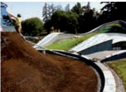
Dazu wurden die bis zu 45° geneigten Flächen des Kegelstumpfes mittels lastabtragenden Schubschwellen ringförmig in Segmente aufgeteilt. Nach Verlegen der Wasserspeichermatte WSM 150 wurden anschliessend die Georaster®-Elemente eingepasst.
