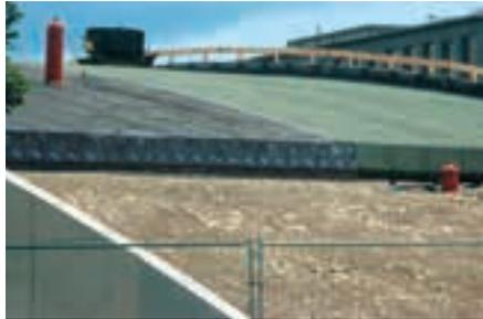
Um das Dach mit dem gewachsenen Boden zu verbinden, wurde der Übergang mit Schotter und Oberboden angeschüttet.
