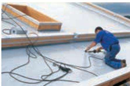
Die zu begrünende Dachfläche wird mit einer gemäss dem FLL-Verfahren auf Wurzelfestigkeit geprüften Dachabdichtungsbahn abgedichtet.
