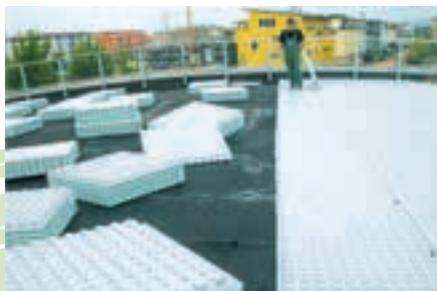
Nach Verlegung der Floratherm®-Elemente wurden anschliessend ca. 15 cm Intensivsubstrat aufgeblasen.
