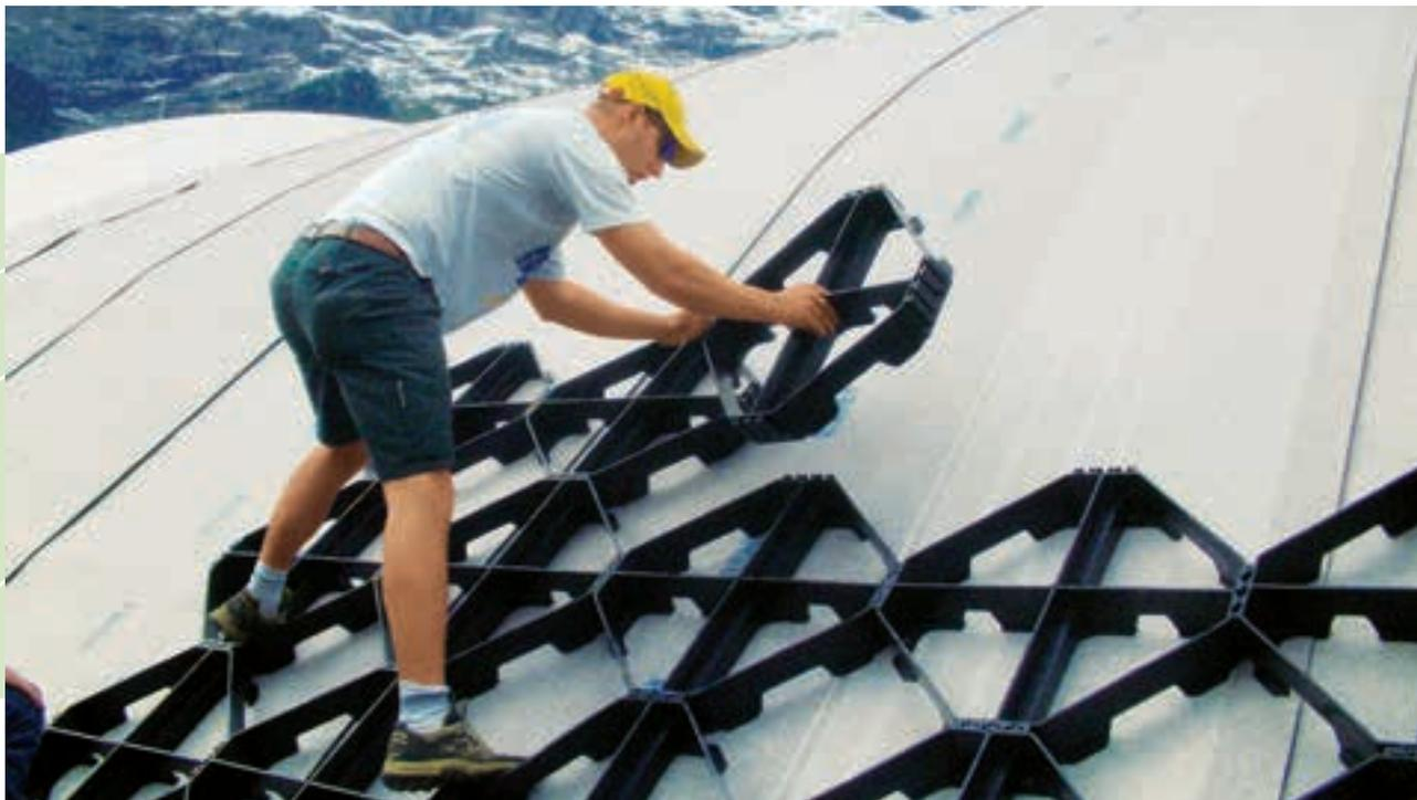
Mit dem hier vorgestellten Systemaufbau „Begrüntes Steildach“ auf Grundlage der ZinCo Georaster®-Elemente wird auch die Begrünung von Dachflächen mit über 25° Neigung möglich. Die ca. 54 × 54 cm grossen und 10 cm hohen Georaster®-Elemente aus Recycling-Polyethylen (HD-PE) werden ohne Werkzeuge einfach ineinandergesteckt. Dies bewirkt sofort einen stabilen, flächigen Verbund.
