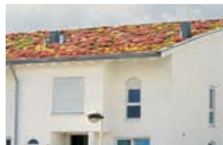
Bei diesem Pultdach wurde knapp oberhalb der Traufe eine Schubschwelle platziert. Die Entwässerung erfolgt über eine aussen liegende Dachrinne.
