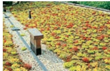
Dieses per Rinne entwässerte Dach mit einer Neigung von ca. 5° erfordert noch keine besonderen Massnahmen.
