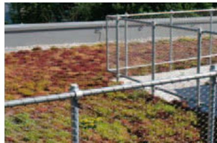
La solution avec les balustrades ZinCo, attrayante et fonctionnelle; fixation sur la toiture sans pénétration de l'étanchéité.
