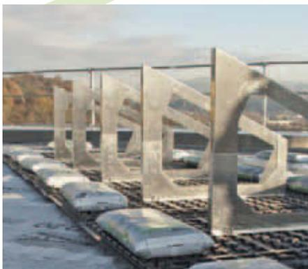
Entweder Solaranlage oder Dachbegrünung? Das war gestern! Mit dem Systemaufbau SolarVert® (Fixodrain® XD 20, ZinCo Solarbasis® und Grundrahmen) erzielen Solarpanels in Kombination mit einer Dachbegrünung sogar einen höheren Wirkungsgrad. Dabei sind nicht einmal Dachdurchdringungen nötig. Denn die erforderliche Auflast für die dauerhafte Standsicherheit der Anlage wird durch die Begrünung erzielt. Die Solarbasen sind auf der Fixodrain®-Ebene beliebig platzierbar.
