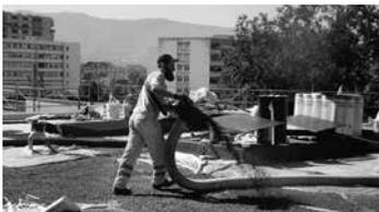
Zincolit®, Zincolit® Plus und Zincoterre® werden in unterschiedlichen Lieferformen angeboten. Abhängig von der Grösse und der Lage einer Dachfläche bzw. dem aufzubringenden Substrat kann zwischen den nachstehenden Möglichkeiten gewählt werden: Offene/lose Ware, im Big Bag oder im Silozug. Das Substrat kann mittels Pumpe auf das Dach aufgebracht werden.
