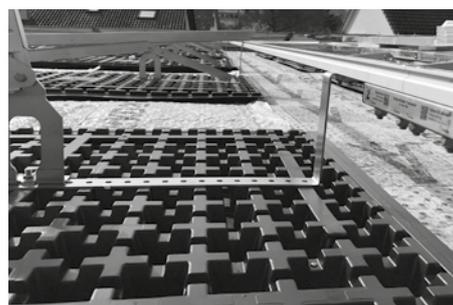
In Kombination mit der ZinCo Solarbasis® SB 200 und Solaraufständerung oder der ZinCo Geländerbasis GB/GB-Eck zu montierendes Schienensystem mit horizontal beweglichem Anschlagpunkt, dem sogenannten Läufer; geprüft als durch Auflast gehaltene Anschlageinrichtung gegen Absturz gemäss DIN EN 795:2012 Typen D und E.
