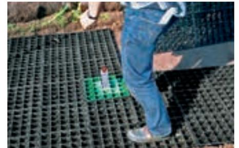
In Summe sind es vier vorgesteckte Elemente, die eine kraftverteilende Scheibe von ca. 5,3 m<sup>2</sup> ergeben.
