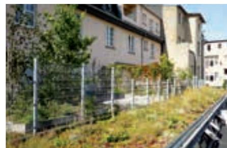
Nach dem abschliessenden Montieren von Fallnet® SB 200-Rail steht den gesicherten Arbeiten im Bereich des Dachrandes nichts mehr im Wege.
