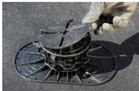
Die auf den Kopf des Elefeet® abgestimmte Dämpfungsscheibe garantiert einen rutschsicheren Halt und ist optimal geeignet als Unterlage für dünnere Keramikplatten.
