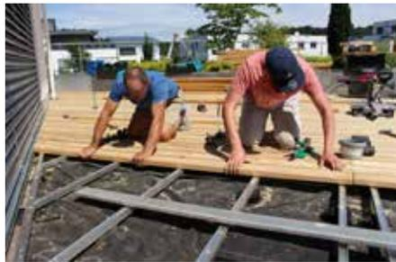
Der Holzbelag kann ohne viel Aufwand einfach und schnell auf dem Schienensystem befestigt werden.
