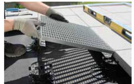
Selbstverständlich lassen sich auf den Elefeet® Stelzlager auch unterschiedliche Beläge wie z. B. Gitterroste und Betonplatten problemlos kombinieren.
