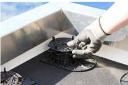
Die neue Elefeet® Fussplatte ermöglicht durch ihre ovale Form das Stellen des Stelzlagers bis zum Dachrand und nach einem Schnitt entlang der markierten Linie, sogar direkt in die Ecken.
