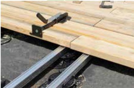
Durch die Flexibilität des Schienensystems kann auch mühelos auf vorgegebene Belagslängen reagiert werden, um einen stabilen Stoss der Beläge zu erhalten.
