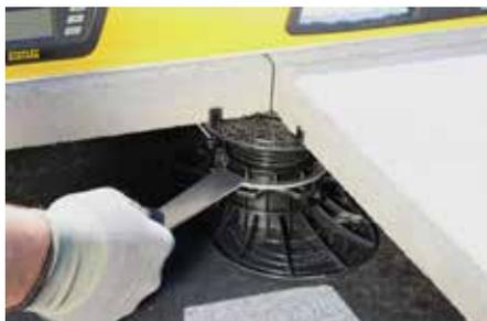
Mit Hilfe des neuen Stellschlüssels ist das nachträgliche Justieren und passgenaue Einstellen der gewünschten Höhe auch bei bereits verlegten Platten problemlos möglich.
