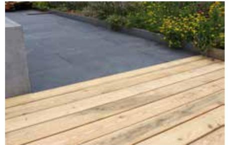
Übergänge unterschiedlicher Gehbeläge sind mit Elefeet® Stelzlagern und dem Elefeet® Schienensystem einfach, stabil und langanhaltend zu realisieren.
