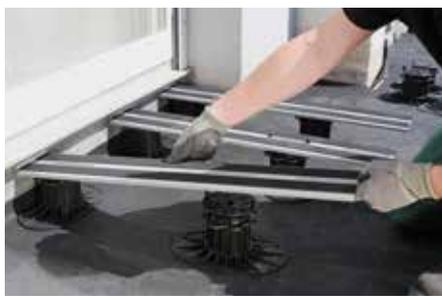
Auch bei relativ grossen Dämmkeilen oder an Türaustritten kann der Belag durch den Kragarm bis an die Aufkantung herangeführt werden. Wird darauf direkt eine Rinne verlegt, kann die Anschluss-höhe auf 5 cm reduziert werden.
