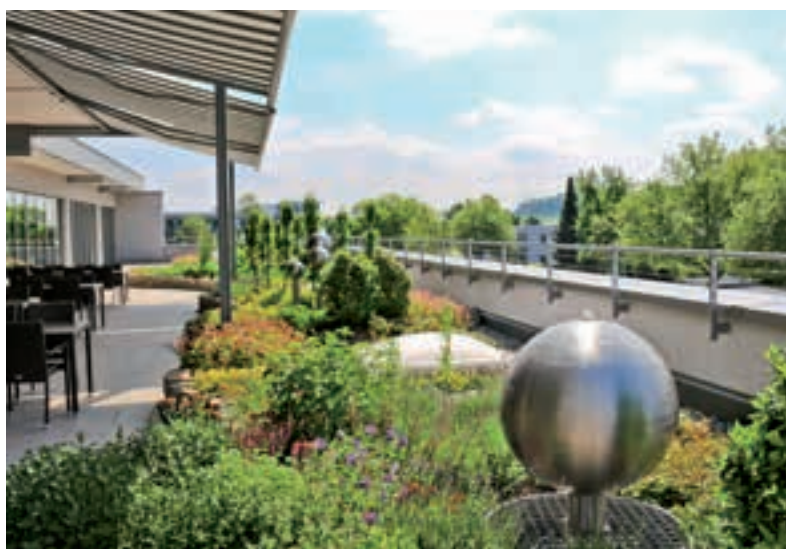
Tetto verde intensivo
