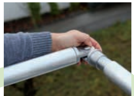
Der Eckverbinder ermöglicht eine kraftschlüssige Verbindung von Handlauf und Kniestab.
