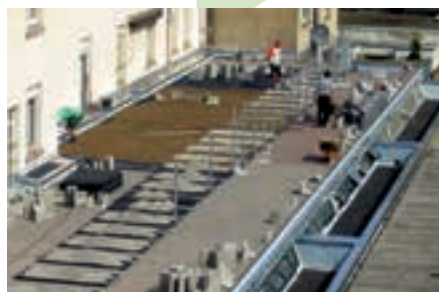
Zur Lagestabilisierung werden die Elemente mit Splitt verfüllt. Dieser dient gleichzeitig als Bettungsmaterial für die im Anschluss zu verlegenden Gehbelagsplatten.
