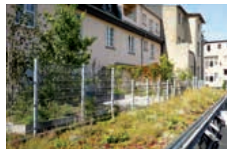
Nach dem abschliessenden Montieren von Fallnet® SB 200-Rail steht den gesicherten Arbeiten im Bereich des Dachrandes nichts mehr im Wege.
