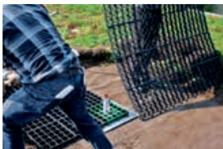
So mittig platziert, werden die weiteren Elemente mit dem Ausgangsraster-element verbunden.
