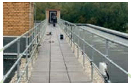
Für die beidseitige Geländereinfassung eines Fluchtweges wurde die Pfostenaufnahme der Geländerbasis GB objektspezifisch mit einem zusätzlichen, zweiten Schraubflansch gefertigt.
