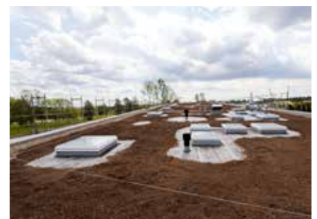
Die fertig eingebaute Zincoterre® „Steinrosenflur“.
