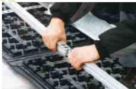
La protezione anticaduta può essere facilmente combinata con la struttura di sostegno ZinCo grazie al sistema modulare.
