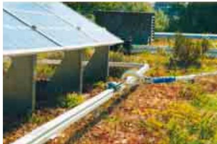
Utilizzo del dispositivo di ancoraggio. Il cursore mobile orizzontale per l'equipaggiamento personale anticaduta assicura la massima praticità di utilizzo.
