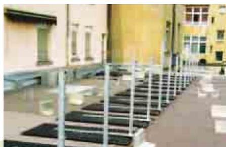
Dopo la posa di uno strato protettivo sull'impermeabilizzazione del tetto, vengono posizionate le basi ringhiera GB / angolo GB e installati i montanti, inclusi ev. i supporti per il binario.
