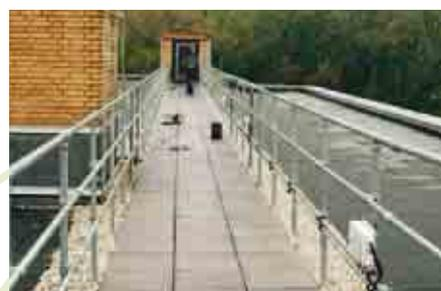
*Per la delimitazione di una via di fuga su entrambi i lati, il supporto montante della base ringhiera GB è dotato di una seconda flangia a vite.*
