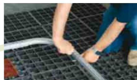
Il Fallnet® SR Rail è assemblato facilmente senza l'uso di utensili speciali. Le grandi superfici possono essere dotate rapidamente di grigliati, supporti per le guide e guide.
