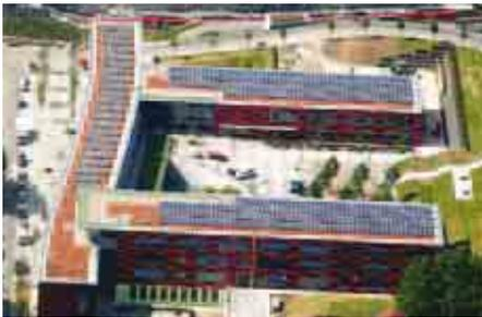
Per sfruttare appieno le superfici dei tetti, gli impianti solari vengono spesso installati anche in prossimità del perimetro.
