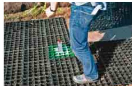
Il risultato è una piastra di ca. 5,3 m<sup>2</sup>, composta da quattro elementi preassemblati, per la distribuzione della trazione.
