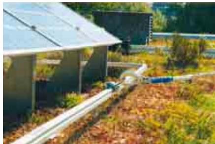
Die Anschlageinrichtung im Einsatz. Der horizontal bewegliche Läufer für die persönliche Schutzausrüstung sorgt für maximale Benutzerfreundlichkeit.
