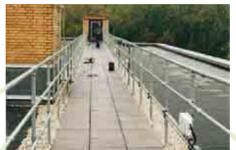
Für die beidseitige Geländereinfassung eines Fluchtweges wurde die Postenaufnahme der Geländerbasis GB objektspezifisch mit einem zusätzlichen, zweiten Schraubflansch gefertigt.
