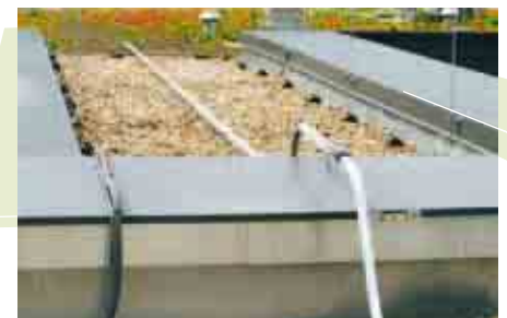
Durch ein schwanenhalsförmiges Schienelement kann ein Höhenversprung elegant bewältigt werden, da der Läufer ohne Unterbrechung weiter gleiten kann.
