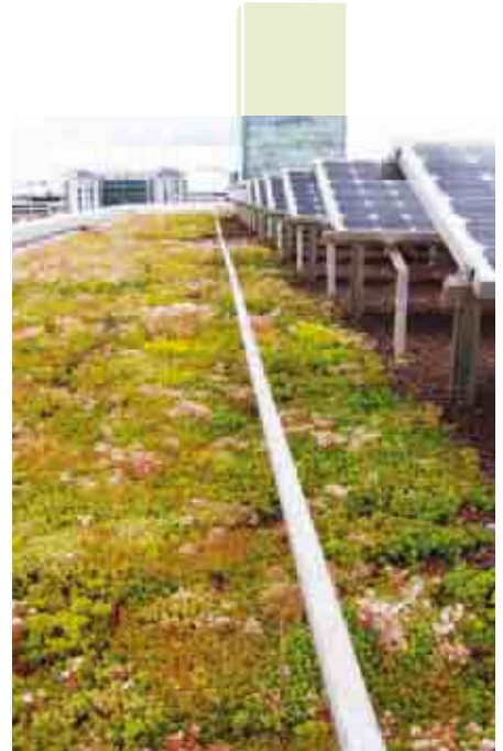
Das klassische Einsatzgebiet des Fallnet®-Schienensystems: Randbereiche, an denen immer wieder gearbeitet werden muss. Einmal im Läufer eingeklinkt, sind sämtliche Tätigkeiten absolut sicher auszuführen.
