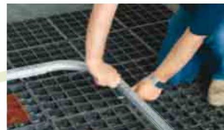
Das Fallnet® SR Rail wird mit einfachen Handgriffen ohne Spezialwerkzeug zusammengebaut. Schnell sind grosse Abschnitte durch Rasterelemente, Schienenhalter und die Schienen miteinander verbunden.
