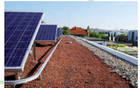
Dachdurchdringungsfreier Einbau, da die nötige Auflast lediglich mit Zincolit bzw. Zincoerre® oder alternativem Schüttgut erbracht wird.
