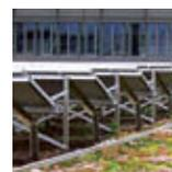
Werden die Modulreihen zu eng angeordnet, kann dies zu Verschattung führen, was die Effektivität stark vermindert.
