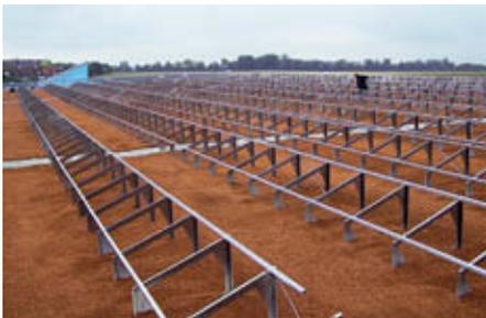
4. Entsprechend der notwendigen Auflast werden die Solarbasisplatten mit Zincoterra® überdeckt.
