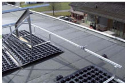
Auch an den Längsseiten der Anlage komplette Sicherheit
