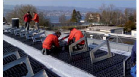
3. Auf den Solarbasisplatten werden die Solar-Grundrahmen platziert und ausgerichtet.
