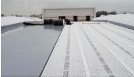
1. Die Dachabdichtung wird mit der hochwertigen Drain- und Schutzlage Fixodrain® XD 20 abgedeckt.
