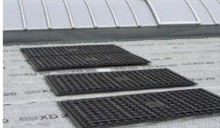
2. Anschliessend werden die Solarbasisplatten ausgelegt.
