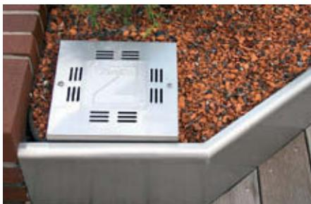
In den Systemaufbau integrierter Kontrollschacht
