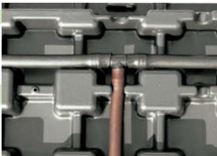
Arretierung der Tropfschläuche in die dafür vorgesehenen Aussparungen. Abschliessend werden die Schläuche mit der Steuertechnik gekoppelt.
