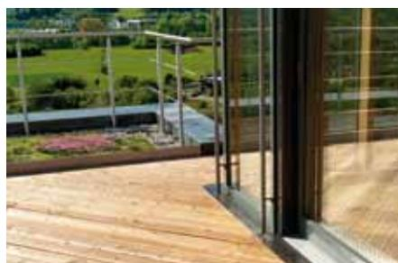
La norme SIA 271 impose de respecter une hauteur de relevé de 60 mm minimum aux paliers de porte. Si c'est im-
