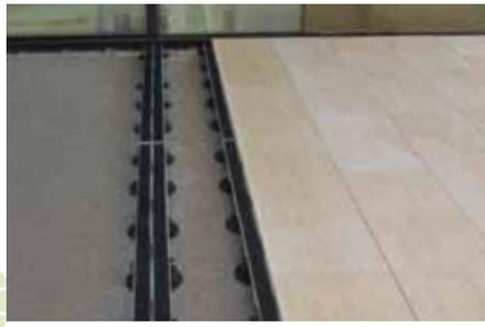
Les appuis de bord en onglet permettent aussi la pose facile de formats spéciaux.
