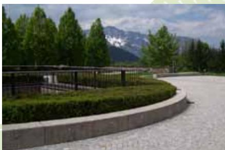
Les bordures bétonnées sur l'élément de drainage fournissent une délimitation fiable.
