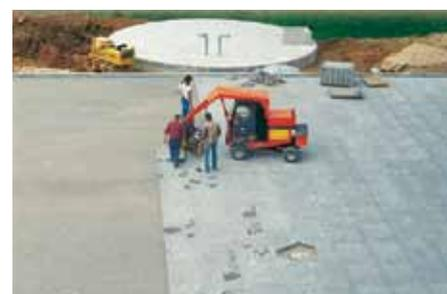
La pose « par l'avant » de la couche porteuse et des couches qui la recouvrent est faisable sur Elastodrain® EL 202 même avec des engins lourds.
