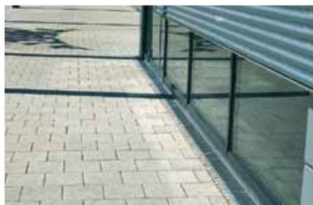
Avec Stabilodrain® SD 30 pour drainer la surface, l'eau s'écoulant sur la façade est évacuée vers le bas par l'intermédiaire de caniveaux et de grilles, et ne pose plus aucun problème.
