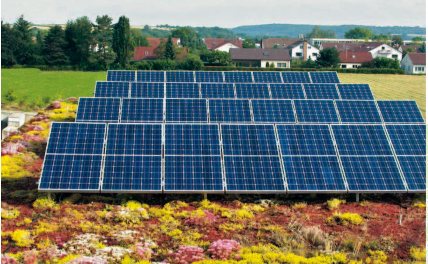
I telai di sostegno per pannelli solari SGR 25/30/45 corrispondono alle inclinazioni standard di 25°, 30° e 45°. Su richiesta i telai di sostegno possono essere forniti con pendenze e dimensioni specifiche all'oggetto.
