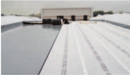
1. Copertura dello strato impermeabilizzante con il telo protettivo drenante Fixodrain® XD 20 di alta qualità
