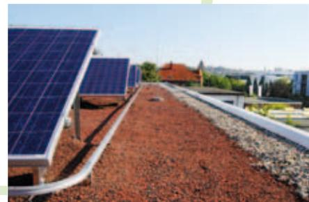
Non è necessario perforare la guaina impermeabilizzante del tetto poiché il carico necessario è assicurato solamente da Zincolit®, ZincoTerre o un altro tipo di materiale di riempimento.
