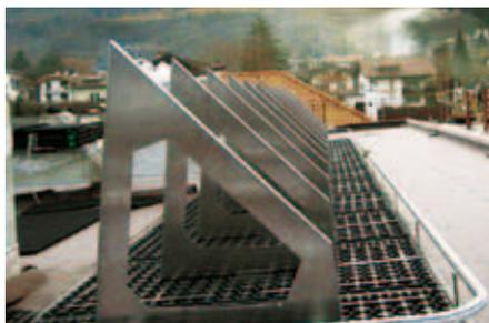
Telaio di 45° per impianti termici solari su una superficie di montaggio con inclinazione di 5°.
