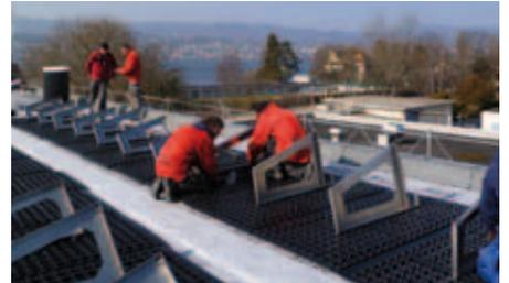
3. Installazione e orientamento dei telai di sostegno sui pannelli di supporto ZinCo Solarbasis®
