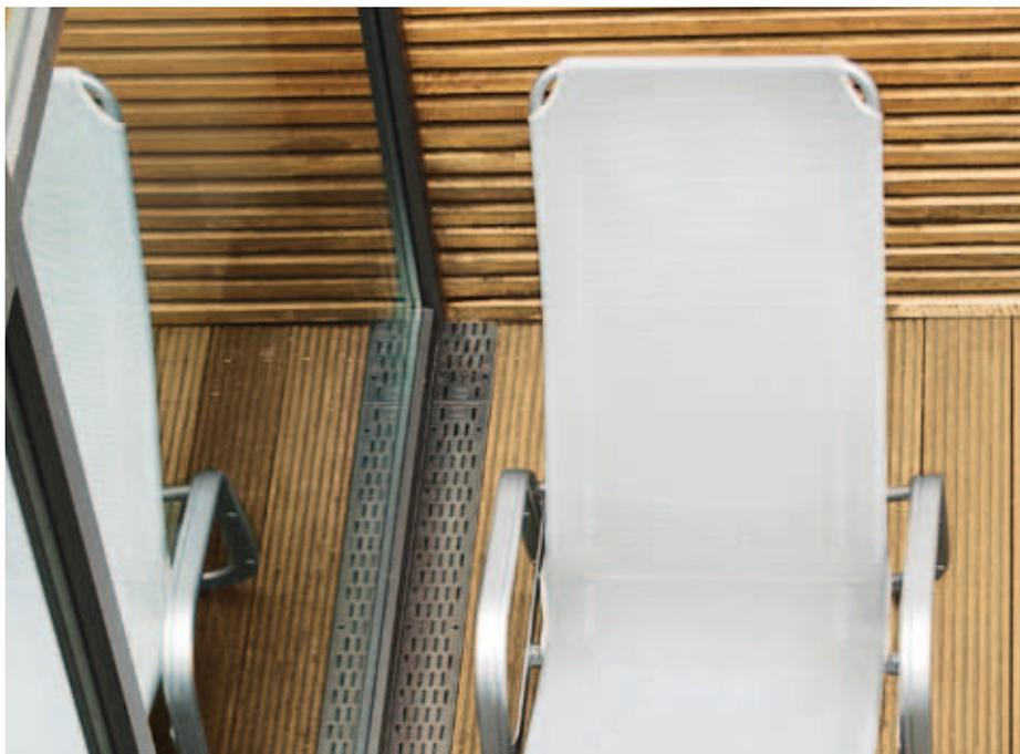
È possibile evitare il ristagno dell'acqua in tutte le aree di delimitazione e di collegamento presenti sul tetto tramite misure protettive adeguate. La gamma di canali di scarico ZinCo offre soluzioni funzionali e durature per tutte le tipologie di tetto.
