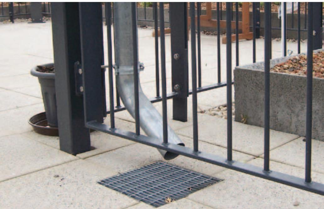
Quando è necessario un rapido deflusso dell'acqua piovana dai rivestimenti calpestabili, per es. sotto i canali di gronda, le griglie per terrazze con altezze fisse rappresentano una soluzione pratica e duratura. Le griglie fisse sono particolarmente adatte anche per la posa di supporti telescopici.
