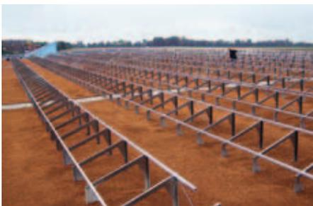
4. Les modules Solarbasis sont recouverts de la quantité de terre nécessaire à un lestage efficace.
