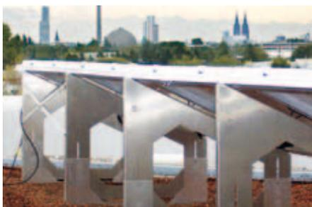
Höhenverstellbare Rahmen z.B. zum Ausgleichen von Dachgefälle.
