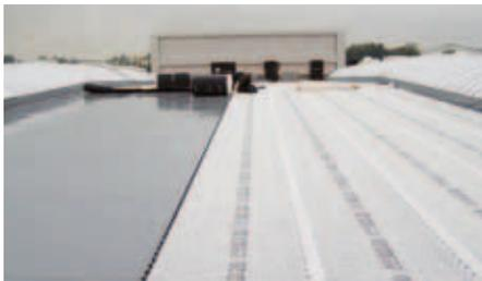
1. L'étanchéité est recouverte par les couches de drainage et de protection de haute qualité Fixodrain® XD 20.
