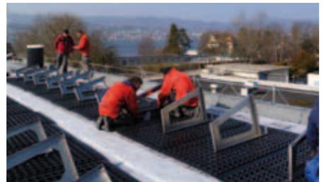
3. Les cadres solaires de base sont placés sur les modules Solarbasis, puis alignés.
