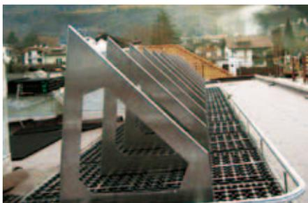
Cadres à 45° pour énergie solaire thermique posés sur surface de montage inclinée à 5°.
