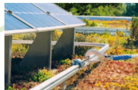
La glissière de déplacement horizontale pour la fixation de l'équipement individuel de protection offre une facilité optimale d'utilisation, car l'utilisateur ne s'y fixe qu'une seule fois et est sécurisé en permanence pour un déplacement le long du rail.
