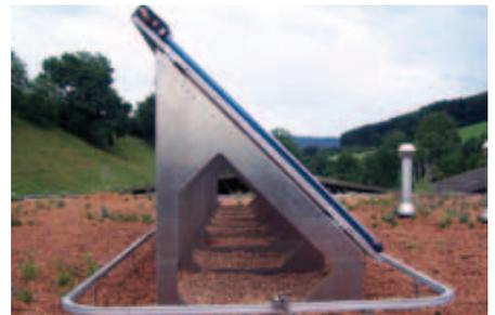
Cadres de base avec angle modifié pour installations solaires thermiques.
