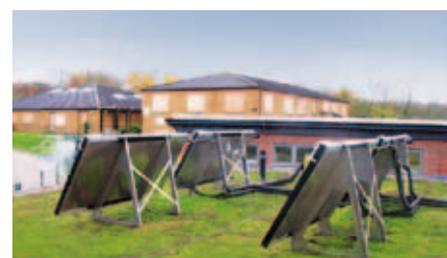
**Utilisation pour système d'énergie solaire thermique.**
