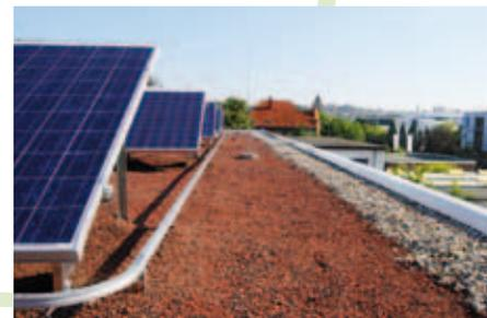
Construction sans pénétrations, car le lestage nécessaire est assuré avec Zincolit® resp. Zincoterre® ou d'autres matériaux.
