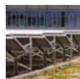
L'efficacité peut être fortement réduite si l'installation est placée trop près du bord de la toiture ou si le nombre de modules est surdimensionné.
