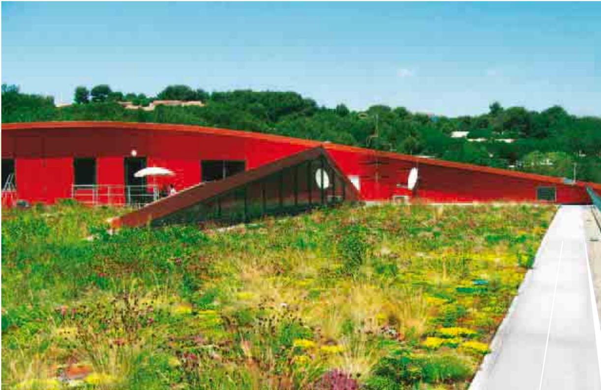
Mit der „Steinrosenflur“ lässt sich eine gestalterisch anspruchsvolle Extensivbegrünung mit individuellem Charakter realisieren. Die Substrathöhe im Systemaufbau liegt bei mind. 8 cm Zincoterre® „Steinrosenflur“. Die „Steinrosenflur“ kommt vor allem dort zum Einsatz, wo Arten bewusst eingesetzt werden sollen. Möglichst viele verschiedene Arten sorgen für eine lange Blütezeit.
