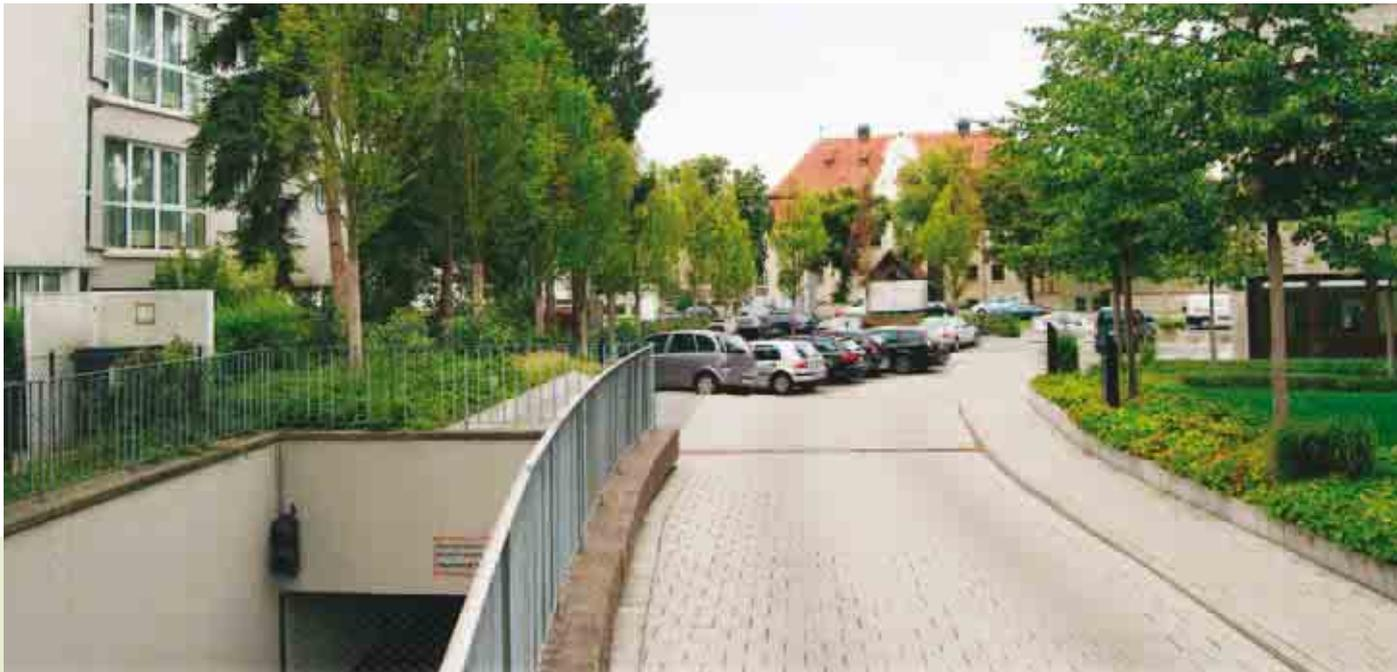
Fahrbeläge auf Dachflächen erfordern nicht nur einen tragfähigen Systemaufbau. Auch Kriterien wie die Tragfähigkeit der Dachkonstruktion oder horizontale Lasten, die durch Bremsen, Lenken und Beschleunigen entstehen, müssen berücksichtigt werden. Die Wahl der richtigen Steindicke und Verlegeart stellt sicher, dass die Pflasterung in ihrer Form erhalten bleibt.
