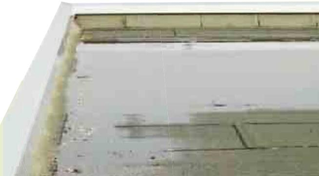
Auf 0°-Dächern, auf denen mangels Gefälle tiefere Pfützen zurückbleiben, muss der Standard-Systemaufbau abgewandelt werden. Durch den Einbau der 5 cm bzw. 7,5 cm hohen Floraset®-Drainage-Elemente wird der notwendige Abstand zum stehenden Wasser sicher-
