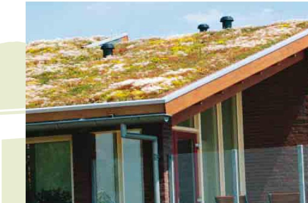
Zwar werden Extensivbegrünungen meist auf Flachdächern aufgebracht, sie sind jedoch genauso auf geneigten Dächern einsetzbar. Ab etwa 10° Neigung muss hierbei jedoch der Schichtaufbau an die veränderten Bedingungen angepasst werden. Zum Einsatz kommen dann schubabtragende Floraset® FS 75-Ele-
