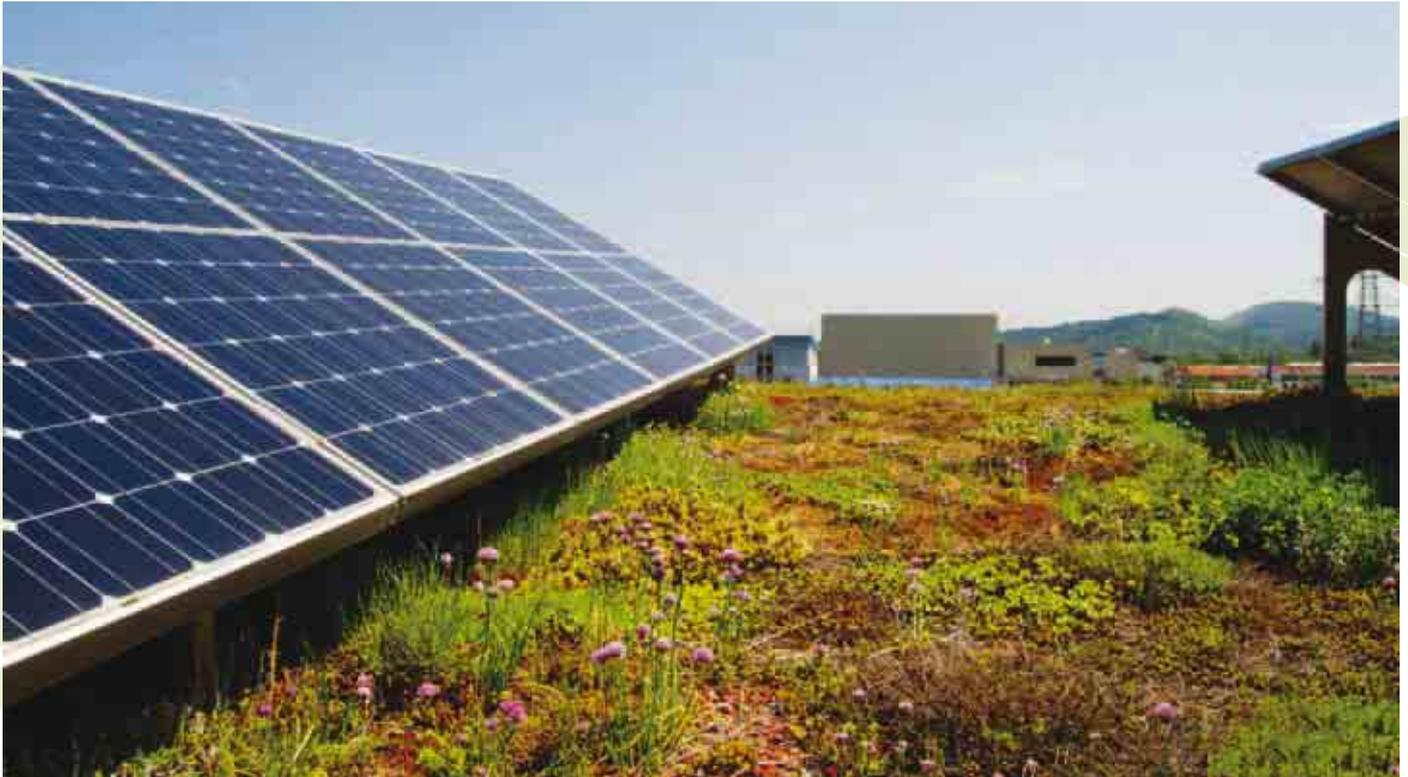
Kombiniert man eine Solaranlage mit einer Dachbegrünung, ergeben sich wichtige Synergieeffekte. Die Vegetationsschicht übernimmt die nötige Auflast zur Windsogsicherung. Dadurch ist keine Dachdurchdringung nötig und schwere Einzellasten wie Betonklötze entfallen.
