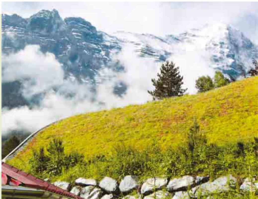
Mit dem hier vorgestellten Systemaufbau „Begrüntes Steildach“ auf Grundlage der ZinCo Georaster®-Elemente wird auch die Begrünung von Dachflächen mit über 25° Neigung möglich. Die ca. 54 x 54 cm grossen, 10 cm hohen Georaster®-Elemente aus Recycling-Polyethylen (HD-PE) werden ohne Werkzeuge einfach ineinandergesteckt. Dies bewirkt sofort einen stabilen, flächigen Verbund. Eine mit den Raster-Elementen belegte Fläche ist sicher begehrbar und mit Zincoterre® befüllbar.
