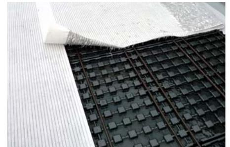
Über die mit Dochtvlies abgedeckten Aquatec®-Platten wurde die Zincoterre® „Dachgarten-Spezial“ aufgebracht.
