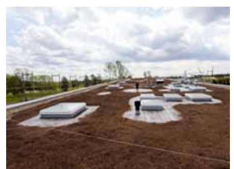
Die fertig eingebaute Zincoterre® „Steinrosenflur“.
