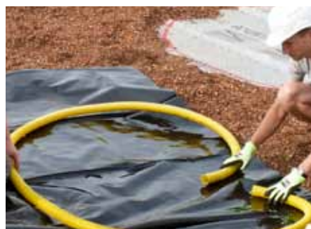
Mit Dränschläuchen und Folien entstehen temporäre Wasserflächen.
