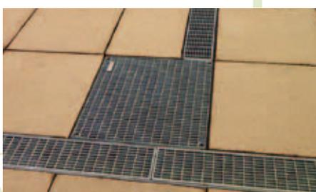
Avec une ouverture des mailles de 11 mm, un contrôle visuel suffit souvent à vérifier que l'évacuation n'est pas bouchée.
