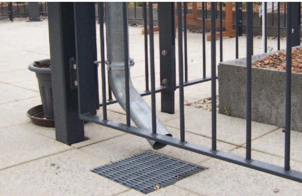
Si vous recherchez un écoulement rapide pour les eaux de précipitations sur les revêtements pour piétons, par exemple sous des tuyaux de réception des eaux pluviales, les grilles de terrasse à hauteur fixe constituent dans ce cas une solution fiable, simple et durable. Les grilles à hauteur fixe se posent également parfaitement sur des plots.
