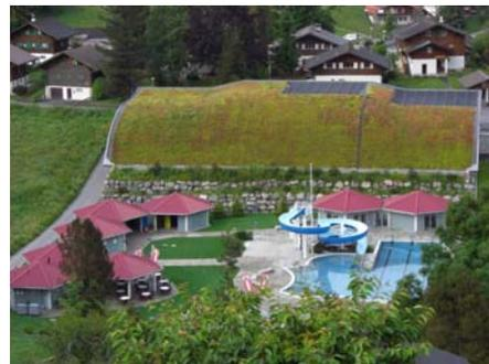
Rechts oben auf dem extensiv begrüntem Dach sind die Warmwasser Kollektoren zu sehen.
